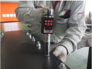
写真 4. トルク確認状況
